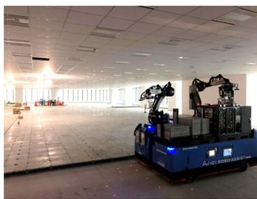
建築現場でのOAフロアロボット施工の様子
