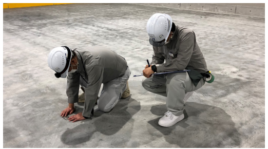
従来の目視による検査状況（実測とスケッチ）
