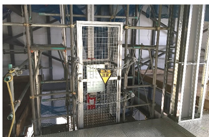
吹抜け足場の一部に組み込んだ例
