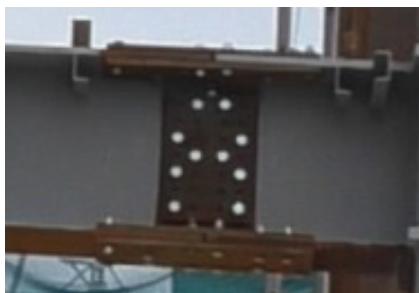
仮ボルトでの仮接合状況
