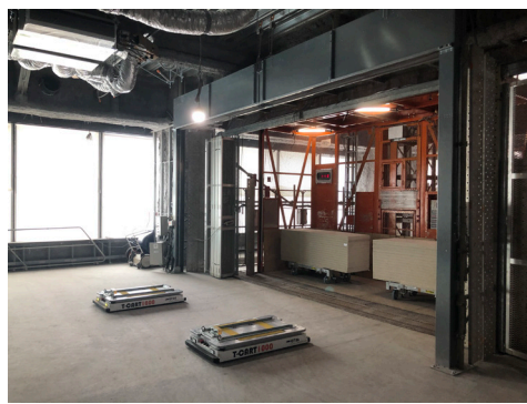
工事用エレベーターへの資材積み込み完了状況
